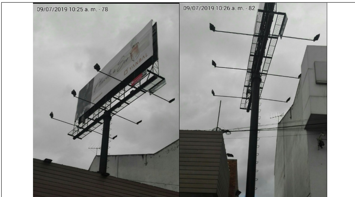
Foto No.1: Vista del predio y de la estructura de la valla tubular, que se encuentra en buenas condiciones y estable, instalada en la Calle 127 No. 70G-69 (dirección catastral), Este-Oeste
